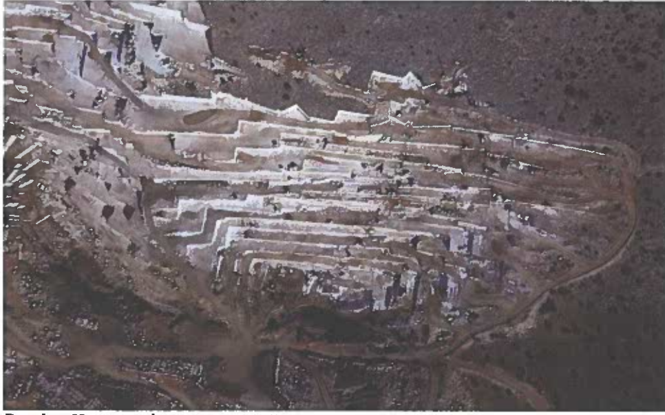
*Burdur Karamanlı mermer ocağı
